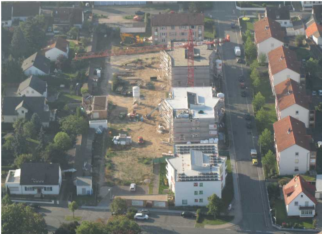
Neue Wohnsiedlung, im Hintergrund ein alter Wohnblock zum Abriss aus den 50'ern
